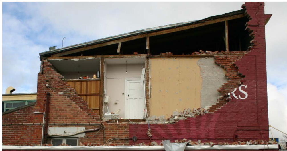
(d) Example of cantilever U-type wall failure for long spanning walls
